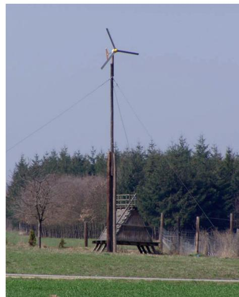
Abbildung 22: Holzmast abgespannt
