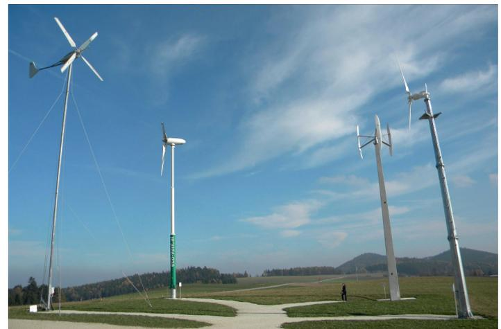
Abbildung 21: Vlnr: Stahlrohrmast abgespannt, Stahlrohrmast klappbar, Betonmast, Stahlrohrmast in Segmenten
