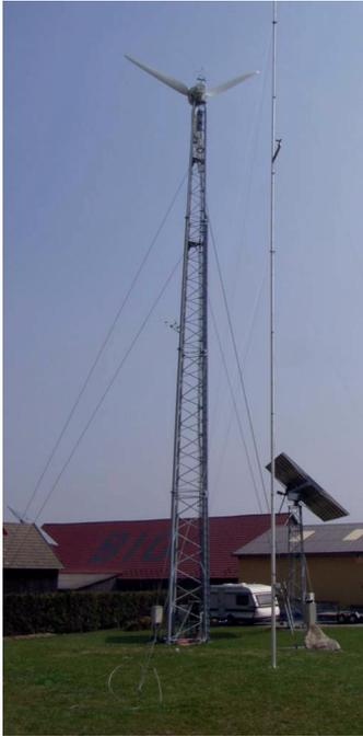
Abbildung 23: Stahlgittermast, abgespannt
