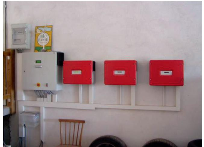
Abbildung 10: 3 Wechselrichter(rot) und Steuergerät (links)
